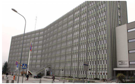
Urząd po remoncie.
