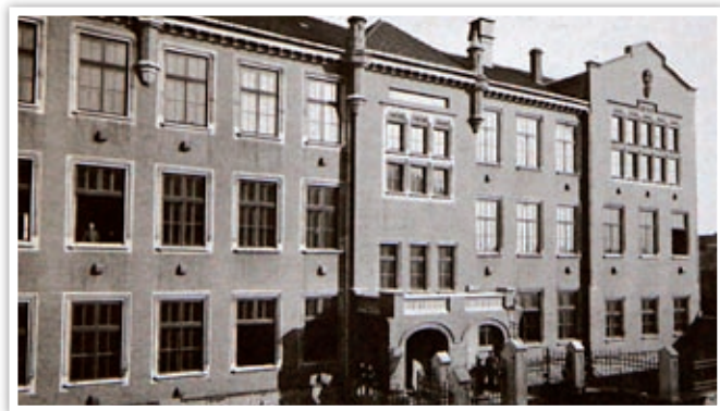
Budynek Szkoły Handlowej w Kielcach.
