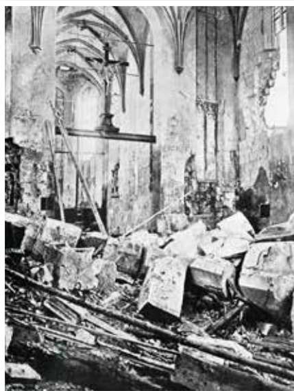
Wnętrze zniszczonego kościoła w Wiślicy
