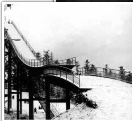
Skocznia narciarska w Kielcach w latach 70. (fot. Wikipedia).
