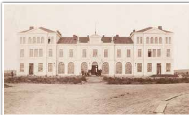
Dworzec kolejowy w Kielcach na fotografii z 1885 r. (Biblioteka Narodowa/Polona).
