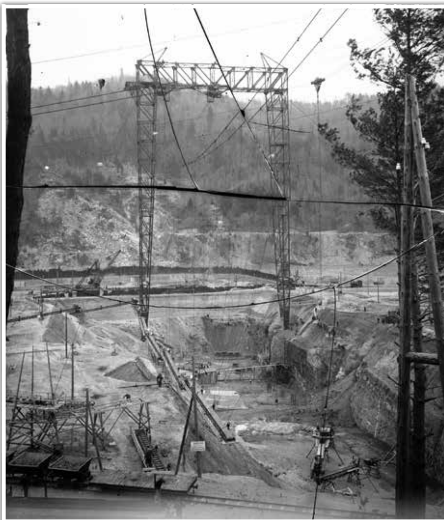
Podpis: Budowa zapory wodnej w Rożnowie na Dunajcu w 1937 r. (fot. NAC).
