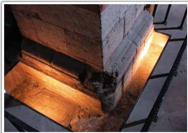
Wyeksponowana płyta nagrobna przy filarze kościoła św. Jakuba.
